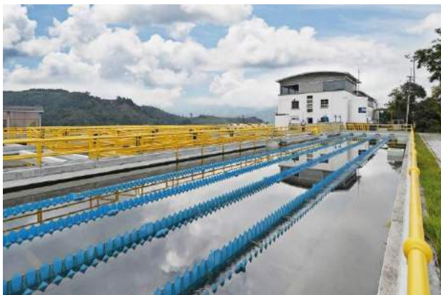
Planta de Tratamiento de Agua Potable Niza Viaducto Manizales, Caldas
