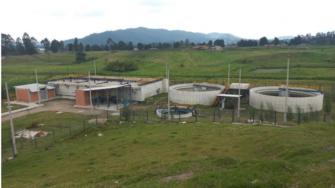
Ilustración No. 33: Vista general de la PTAR Construida – Ene 2024. Facatativá
