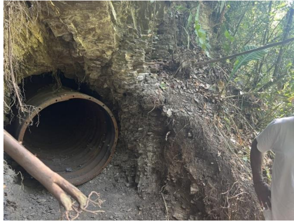
Ilustración No. 32: Salida túnel predio La Julia a Quebrada Socotá – Alcantarillado Anapóima
