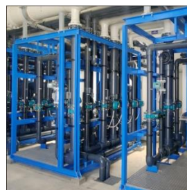
Bastidores de ósmosis inversa y ultrafiltración.
