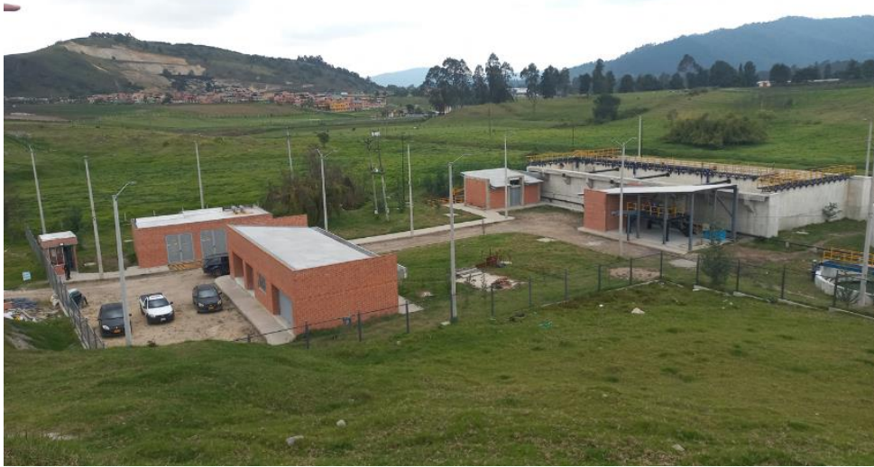
Ilustración No. 33: Vista general de la PTAR Construida – Ene 2024. Facatativá
