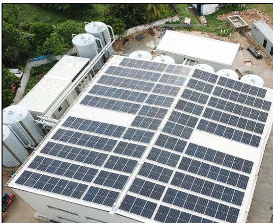
Vista General planta desalinizadora 50 L/s
