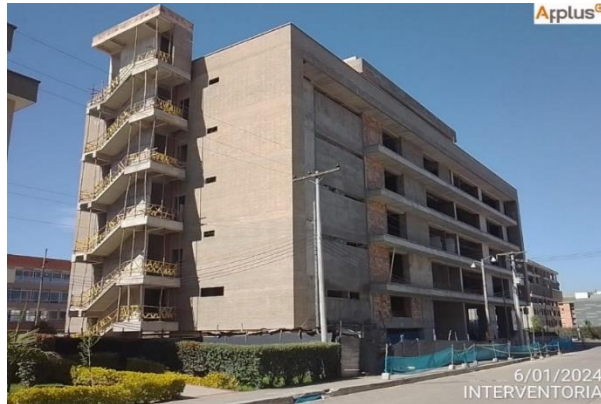
Ilustración No. 28 Edificio del Comando de la Brigada XIII del ejército, ubicado en el cantón norte de Bogotá – enero 2024
