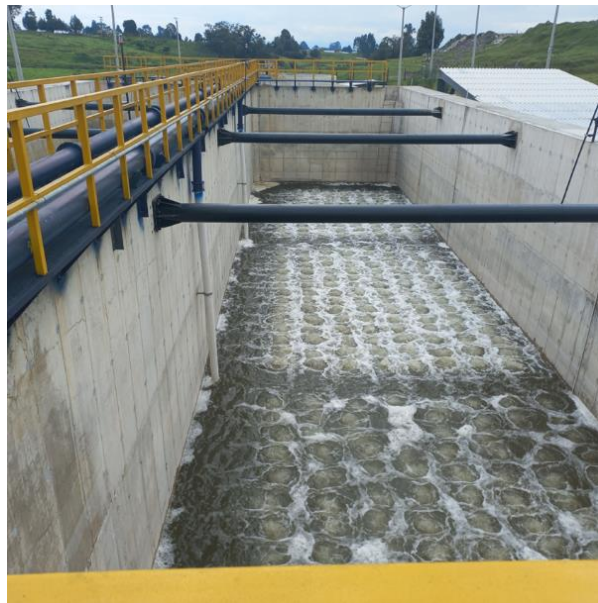
Ilustración No.33 Prueba de funcionamiento tanque de aireación construido – Ene 2024. Facatativá
