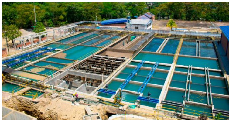
Ilustración No. 46: Modernización de la Planta de Tratamiento de Agua Potable PTAP La Esmeralda y
