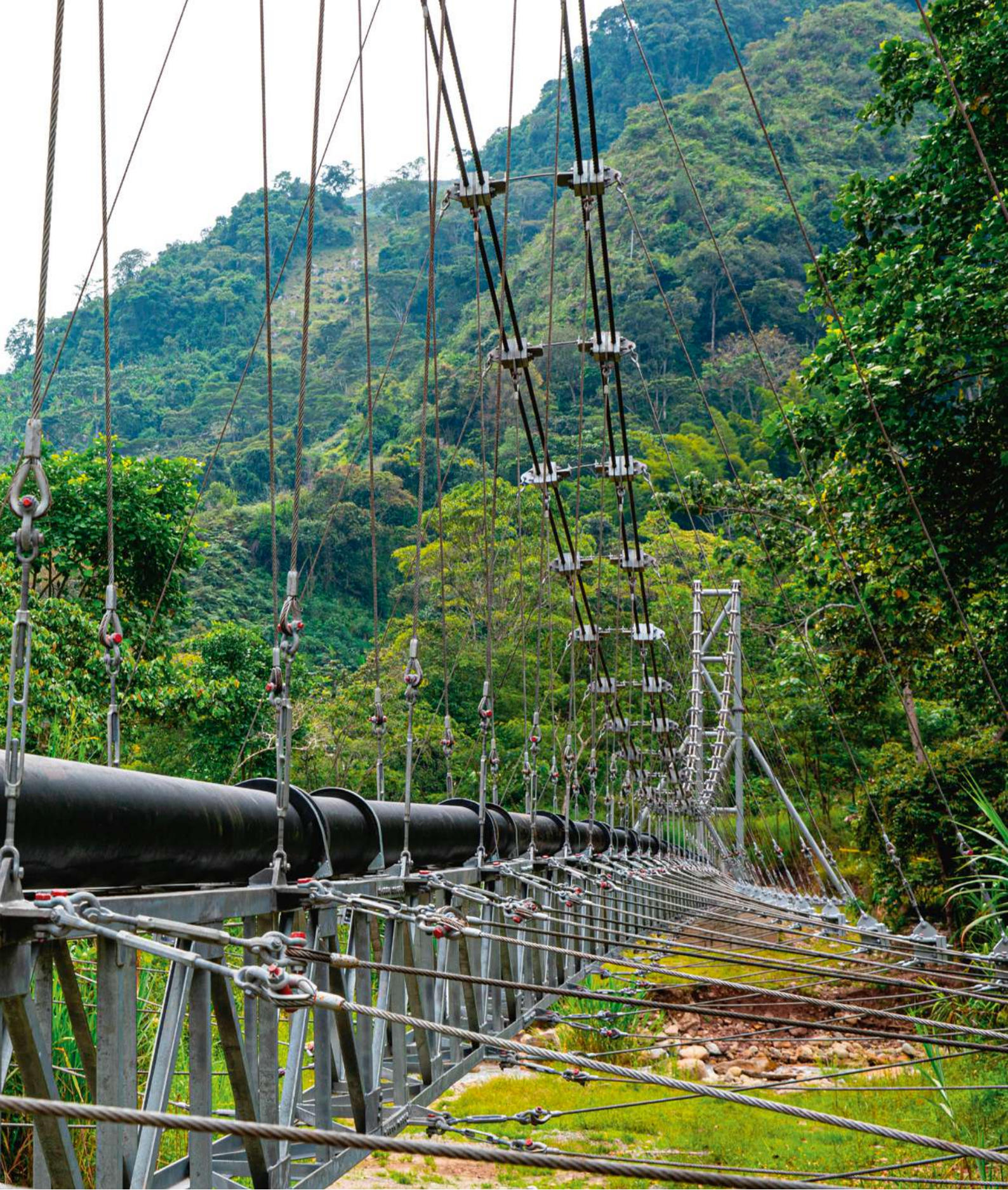
Nuevo acueducto de Socorro (Santander).
