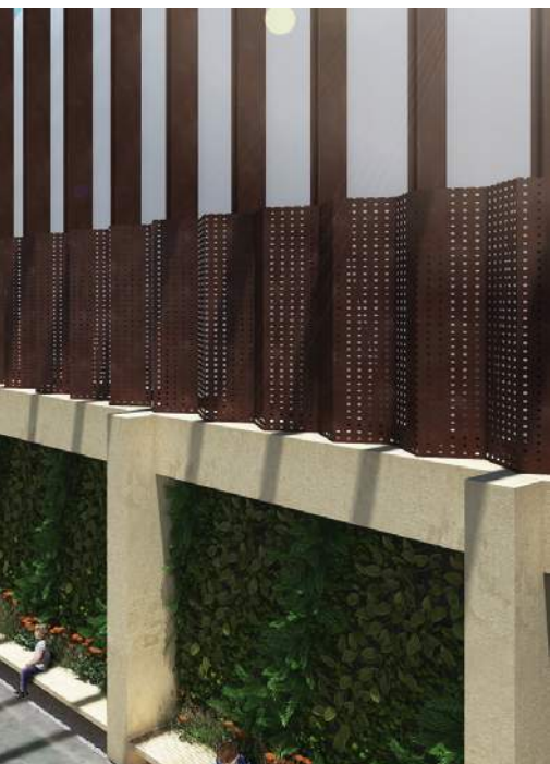
La Fundación Batuta construye en Bogotá la Sala Batuta, proyecto que cuenta con financiación de Findeter.
