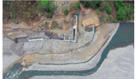
Protección ribereña Acueducto - Yopal, Casanare
