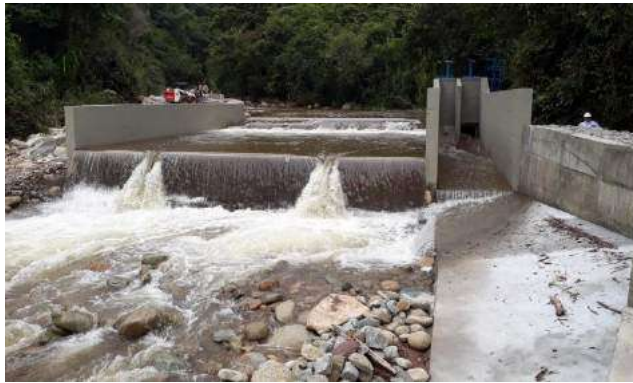
Acueducto (Bocatoma) - Socorro, Santander
