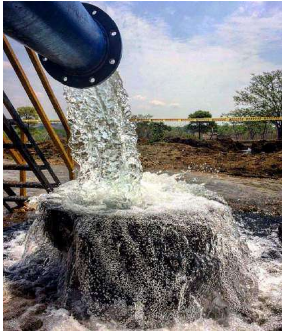
Acueducto Pozo 51 - Sincelejo, Sucre
