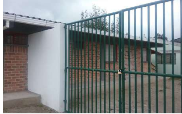
Ilustración 169. Estructura bloque 28 Fuente. Equipo de diagnóstico
