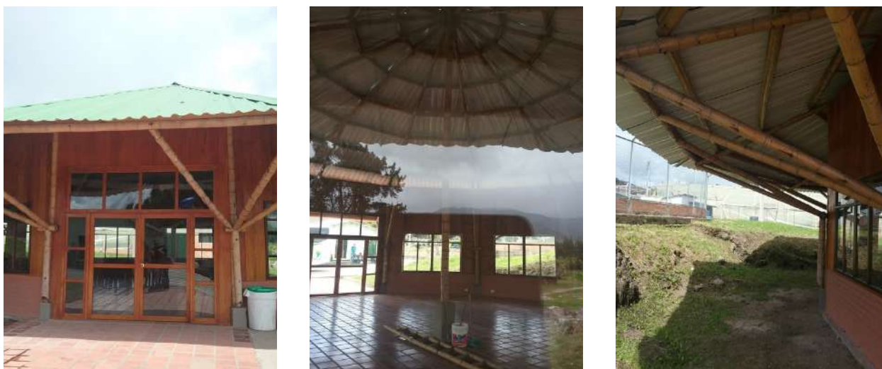
Ilustración 247. Estructura bloque 50 Fuente. Equipo de diagnóstico
