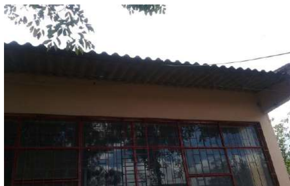
Ilustración 285. Estructura de cubierta bloque 59 Fuente. Equipo de diagnóstico
