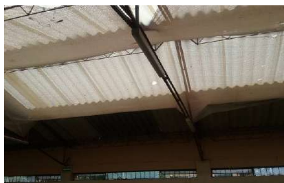
Ilustración 208. Estructura de cubierta bloque 39 Fuente. Equipo de diagnóstico
