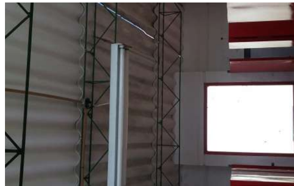
Ilustración 166. Estructura de cubierta bloque 5 Fuente. Equipo de diagnóstico
