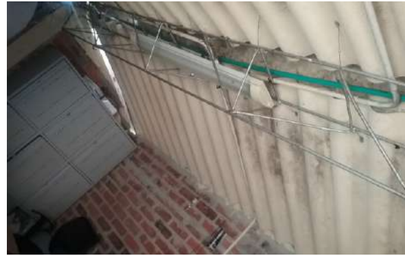
Ilustración 187. Estructura de cubierta bloque 32 Fuente. Equipo de diagnóstico
