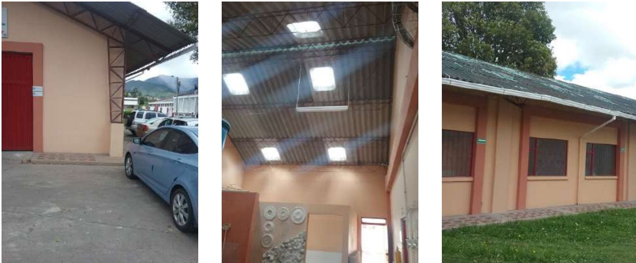
Ilustración 224. Estructura de cubierta Fuente. Equipo de diagnóstico
