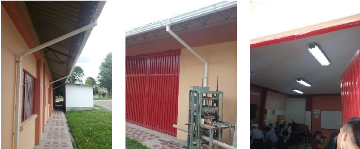
Ilustración 223. Estructura bloque 44 Fuente. Equipo de diagnóstico
