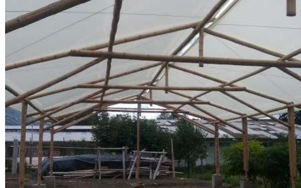
Ilustración 191. Estructura bloque 34 Fuente. Equipo de diagnóstico
