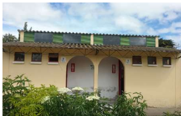
Ilustración 163. Fachada bloque 27 Fuente. Equipo de diagnóstico
