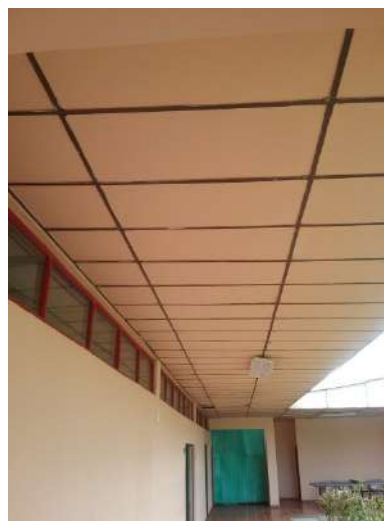
Ilustración 284. Estructura bloque 59 Fuente. Equipo de diagnóstico
