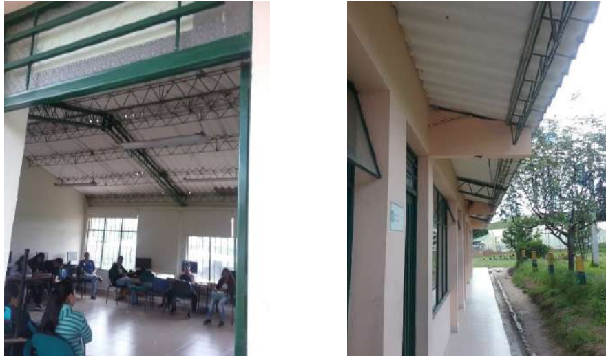
Ilustración 220. Estructura de cubierta Fuente. Equipo de diagnóstico
