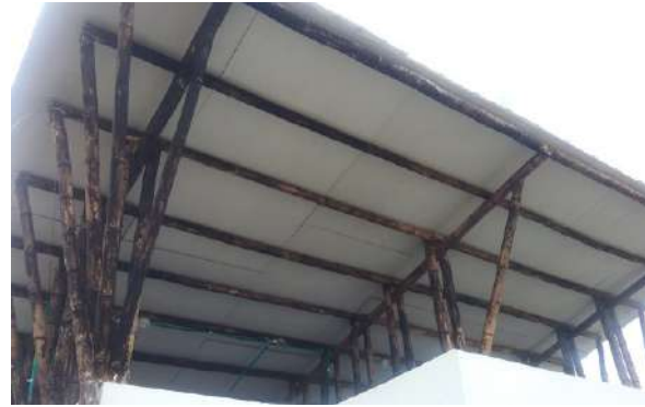
Ilustración 173. Estructura de cubierta Fuente. Equipo de diagnóstico
