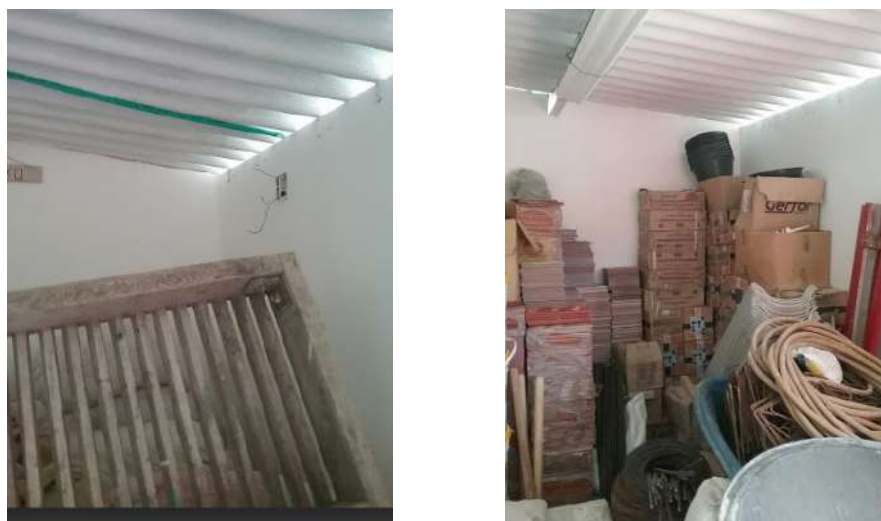
Ilustración 232. Estructura de cubierta Fuente. Equipo de diagnóstico
