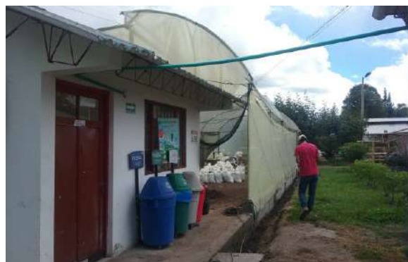
Ilustración 197. Estructura bloque 36 parte A Fuente. Equipo de diagnóstico
