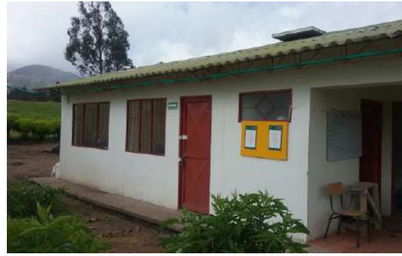
Ilustración 195. Estructura de cubierta bloque 13 Fuente. Equipo de diagnóstico
