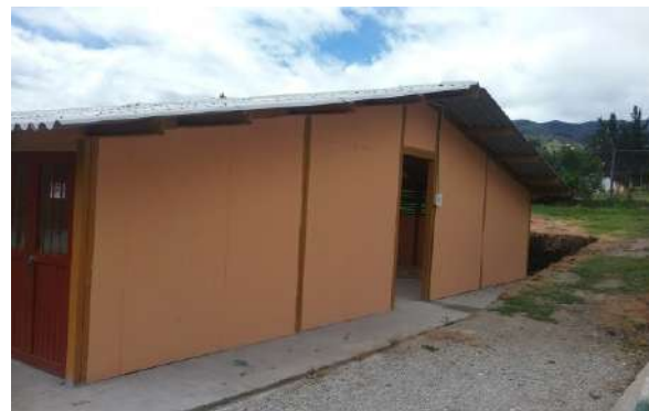
Ilustración 253. Fachada bloque 52 Fuente. Equipo de diagnóstico
