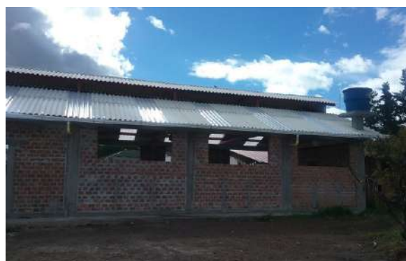
Ilustración 183. Estructura de cubierta bloque 31 Fuente. Equipo de diagnóstico
