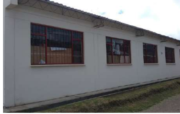
Ilustración 161. Estructura de cubierta Fuente. Equipo de diagnóstico
