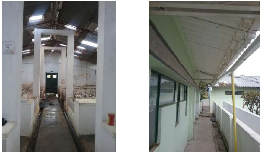
Ilustración 177. Estructura de cubierta bloque 8 Fuente. Equipo de diagnóstico
