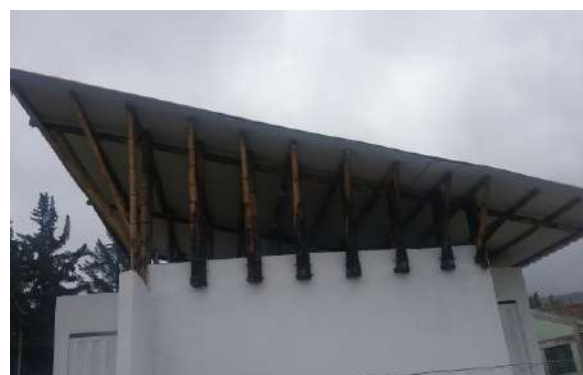
Ilustración 172. Estructura bloque 29 Fuente. Equipo de diagnóstico
