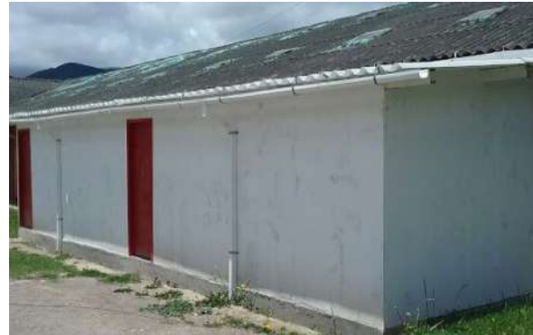
Ilustración 231. Estructura bloque 46 Fuente. Equipo de diagnóstico
