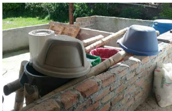
Ilustración 262. Estructura bloque 54 Fuente. Equipo de diagnóstico
