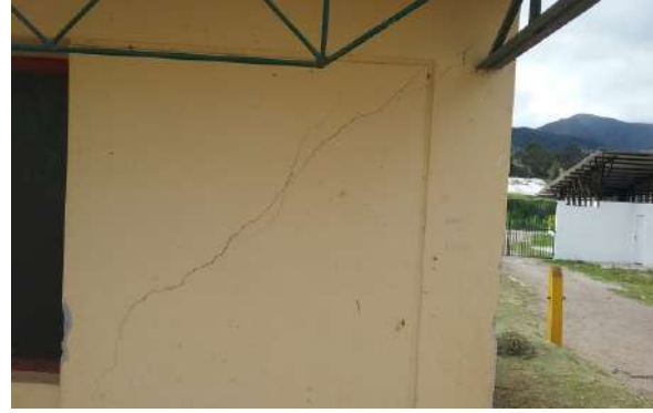
Ilustración 164. Estructura bloque 27 Fuente. Equipo de diagnóstico
