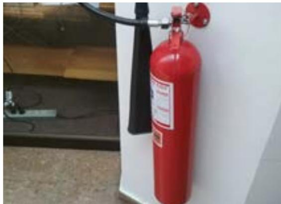
Ilustración 431. Extintor tipo multipropósito.
