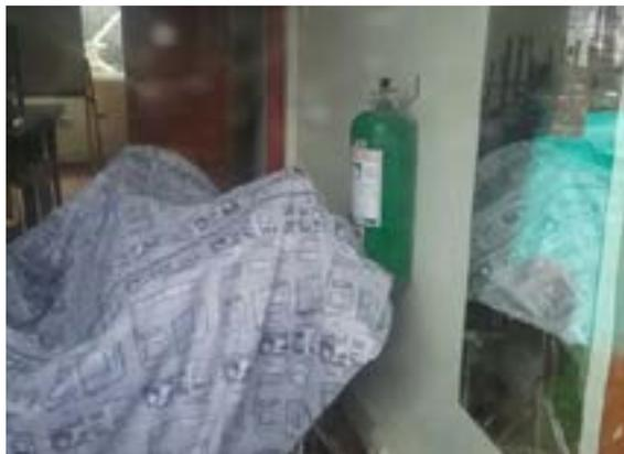
Ilustración 339. Extintor tipo agua a presión.
