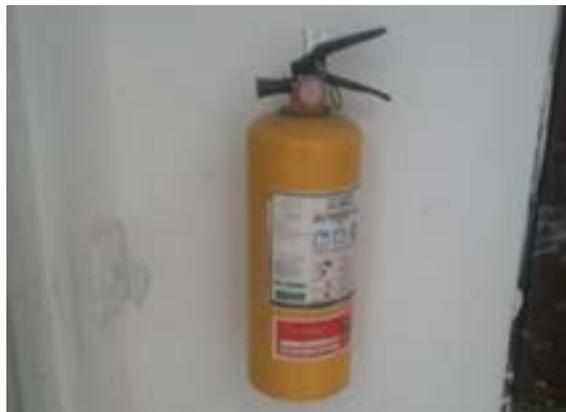
Ilustración 352. Extinguidor tipo multipropósito.
