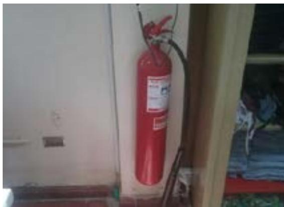
Ilustración 355. Extinguidor tipo co2.
