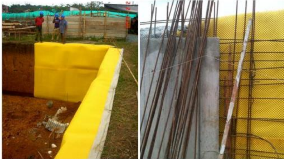
Ilustración 11-3 Instalación filtro Fuente: Eco Geosystems
