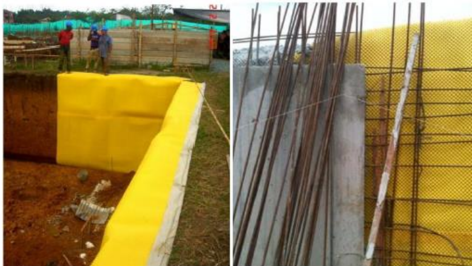
Ilustración 11-3 Instalación filtro Fuente: Eco Geosystems
