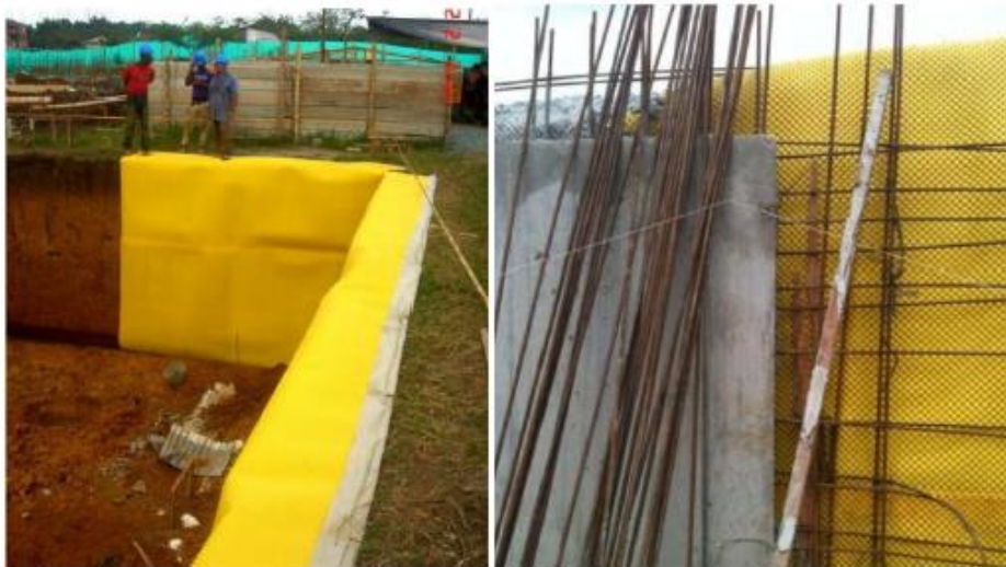
Ilustración 11-3 Instalación filtro Fuente: Eco Geosystems
