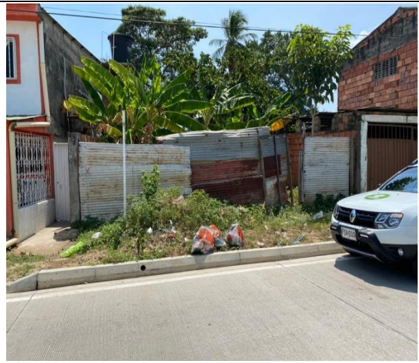
Fotografía No. 1 Entrada al Predio ubicado en la carrera 18 # 28-18 Barrio San Luis Municipio de Arauca - Arauca
