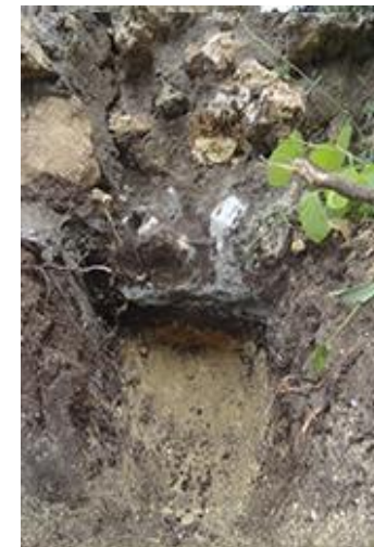
Perforación para muestra de la cimentación de la columna
