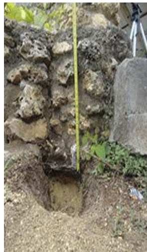
Perforación para muestra de la cimentación de la columna
