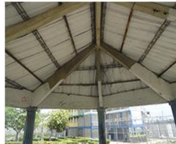
Viga de Cubierta Cumbre
