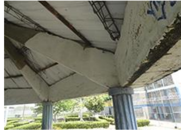
Detalle de apoyo de cubierta sobre columna
