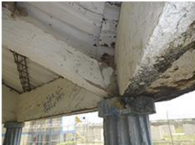
Detalle de apoyo de cubierta sobre columna
