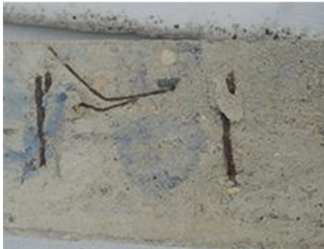
Detalle de acero en viga de cubierta
