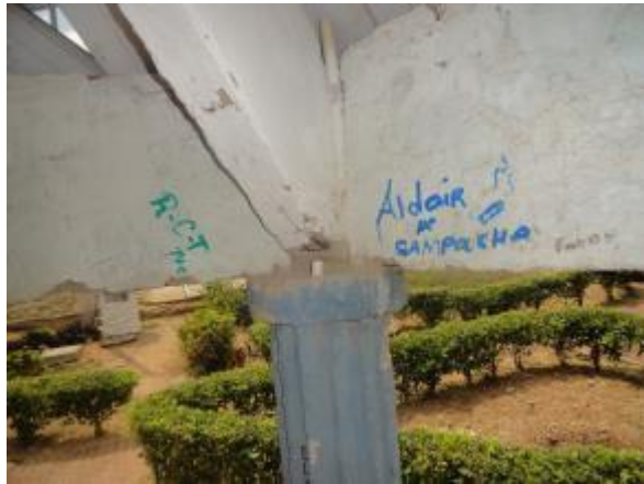
Columna apoyo de cubierta
