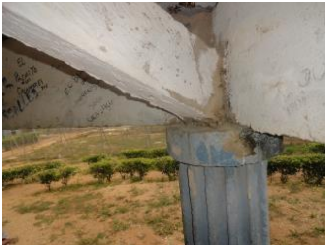
Detalle de apoyo de cubierta sobre columna
