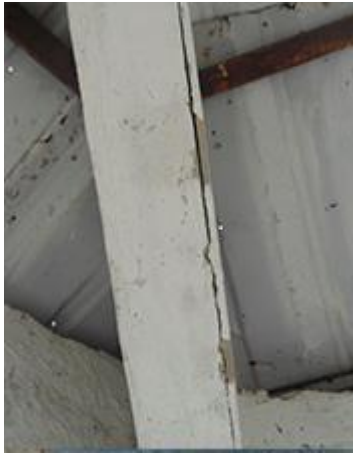
Vista inferior viga de cubierta
