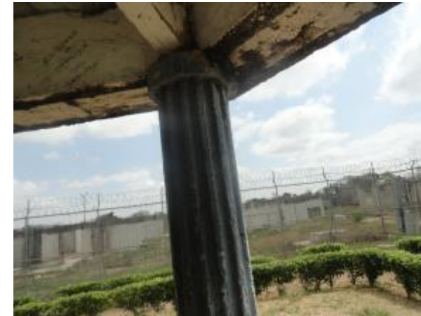
Detalle de apoyo de cubierta sobre columna
