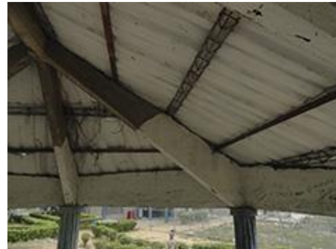
Viga de Cubierta
