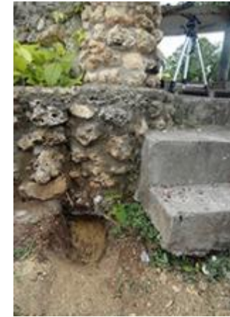
Perforación para muestra de la cimentación de la columna
