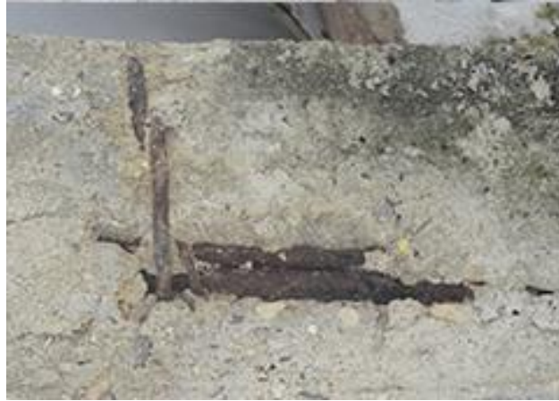
Detalle acero en viga de cubierta
