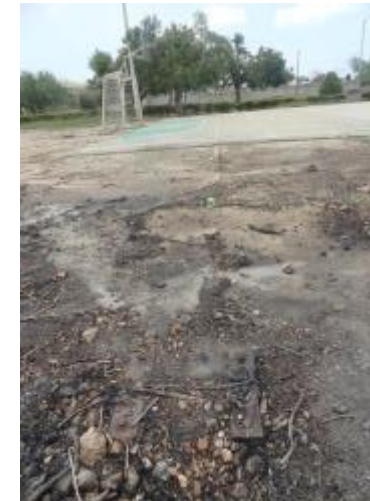
Ubicación de placa metálica
