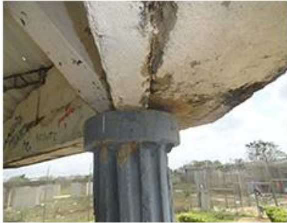
Columna apoyo de cubierta
