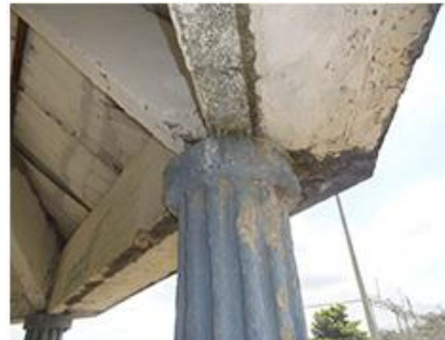
Detalle de apoyo de cubierta sobre columna
