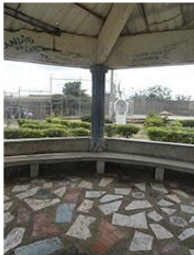
Vista Columna 20x20 recubierta con piedra Kiosco
