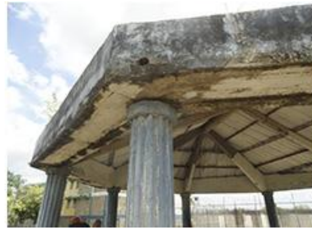
Detalle de apoyo de cubierta sobre columna
