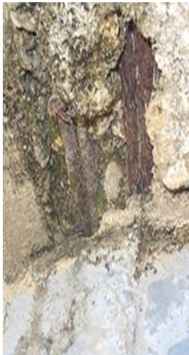
Detalle de acero en viga de cubierta
