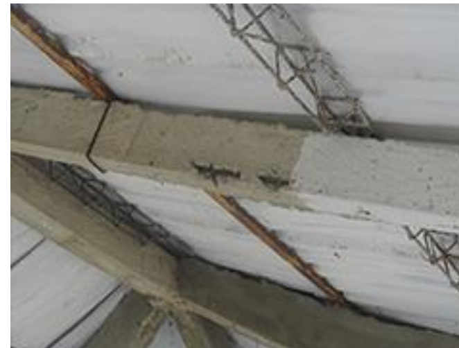
Viga de Cubierta, se observa acero de refuerzo
