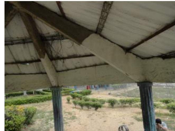
Detalle de apoyo de cubierta sobre columna
