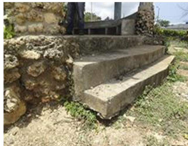
Vista de escalera acceso a kiosco
