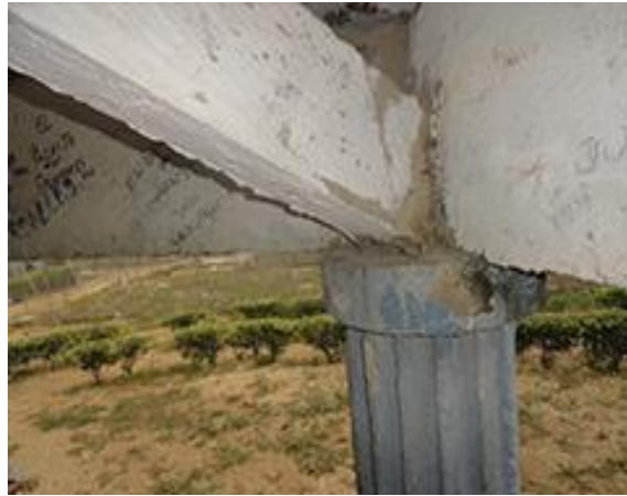
Detalle de apoyo de cubierta sobre columna
