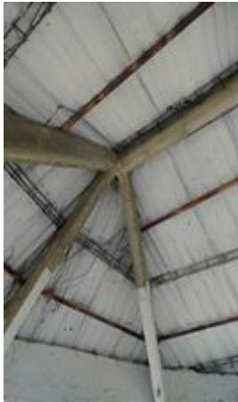
Viga de Cubierta
