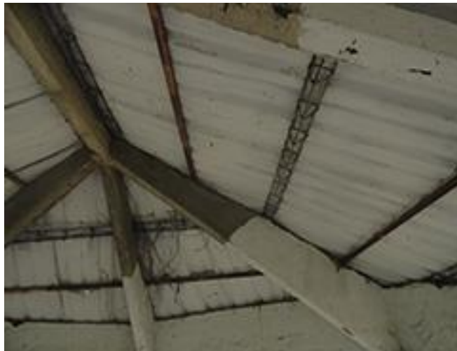
Vigas de Cubierta
