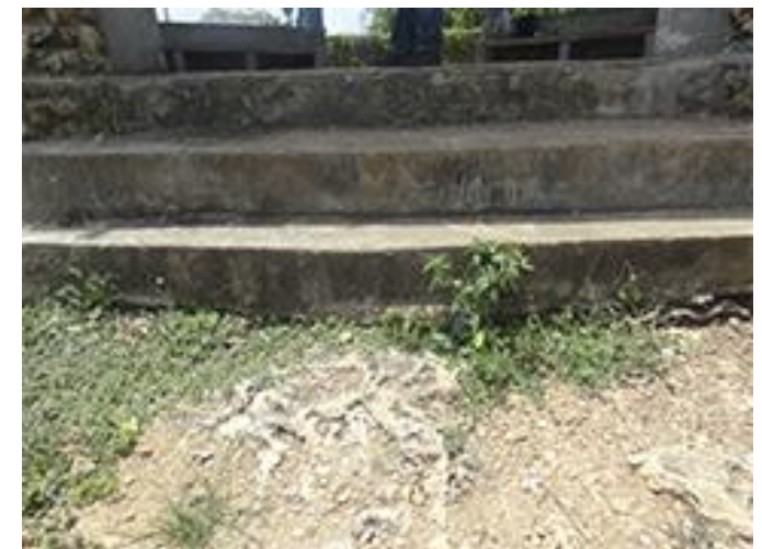
Vista frontal escalera acceso a kiosco
