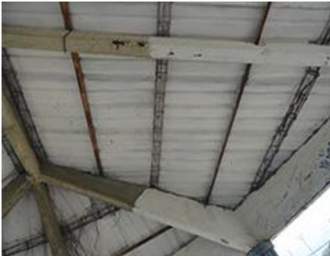
Viga de Cubierta Cumbre
