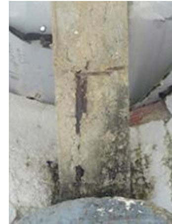
Viga de Cubierta, se observa acero de refuerzo
