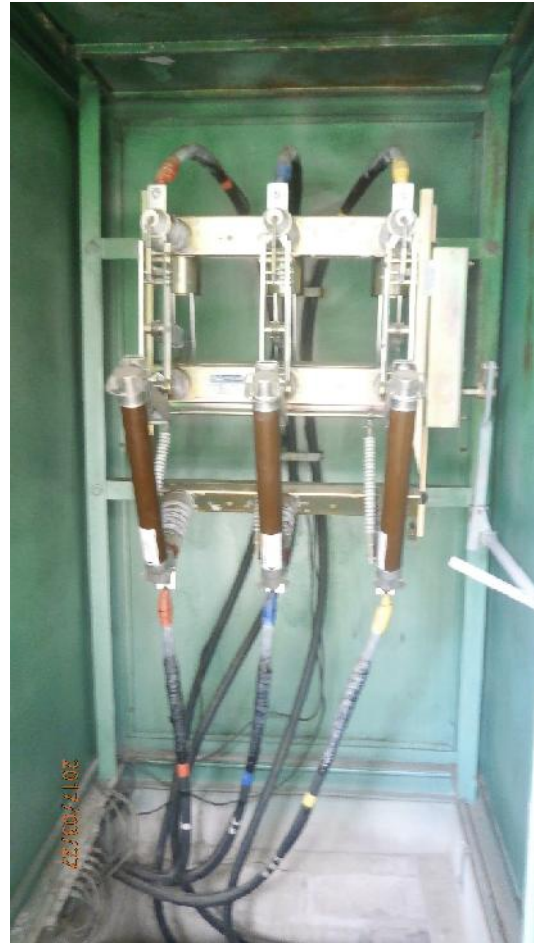
FOTO N.2 TRANSFORMADOR DE 225kVA TIPO SECO Y CELDA DE PROTECCIÓN EN AIRE
