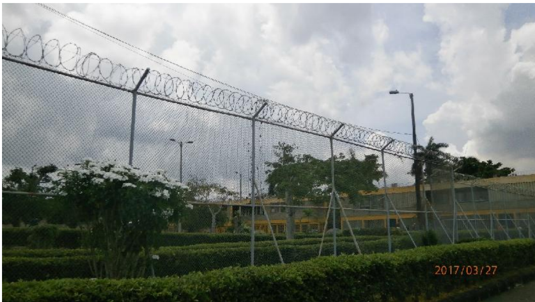
FOTO N.5 POSTES Y LUMINARIAS DE 150W DE SODIO
