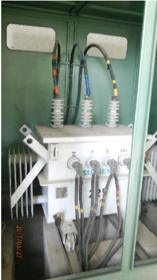
FOTO N.2 TRANSFORMADOR DE 225kVA TIPO SECO Y CELDA DE PROTECCIÓN EN AIRE
