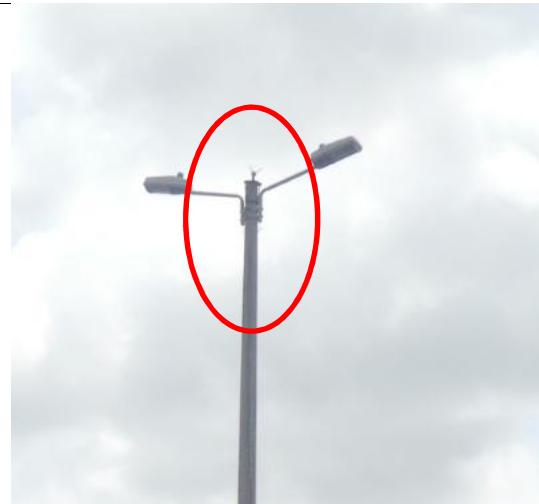
FOTO N.6 POSTE CON PUNTA DE CAPTACIÓN TIPO FRANKLIN
