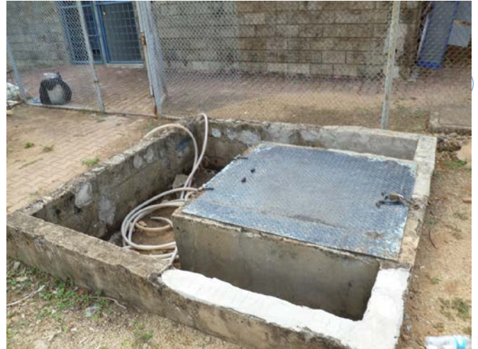
Figura 5. Tapa de acceso tanque bajo de agua potable frente a la PTAP
