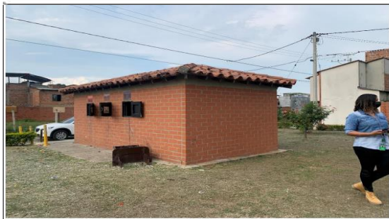
VISTA SHUT DE BASURA QUE SE ENCUENTRA EN EL PREDIO
