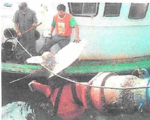
La propela de estribor queda fuera del agua para iniciar el desmonte de las piezas afectadas.
