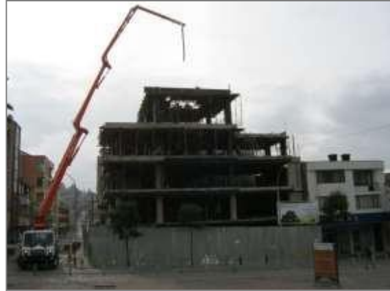
Amarre acero de refuerzo vigas aéreas nivel +15.34M.
