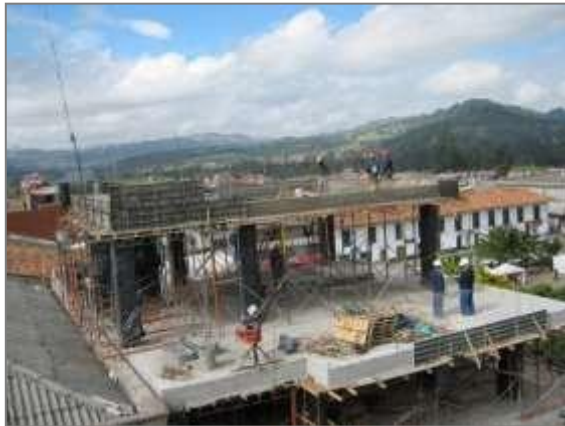
Desencofre vigas aéreas nivel 15.34M.
