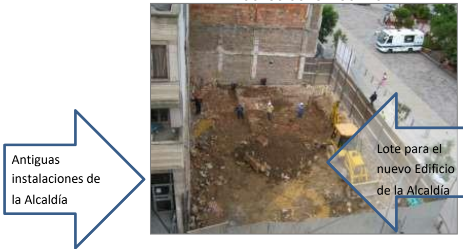
Inicio de la obra
