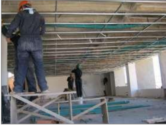
Instalación estructura dry wall nivel +8.81M.
