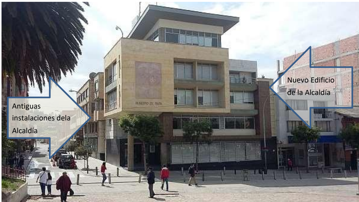
CONSTRUCCION EDIFICIO DE LA ALCALDÍA MUNICIPAL DE PAIPA (TERMINADO)
