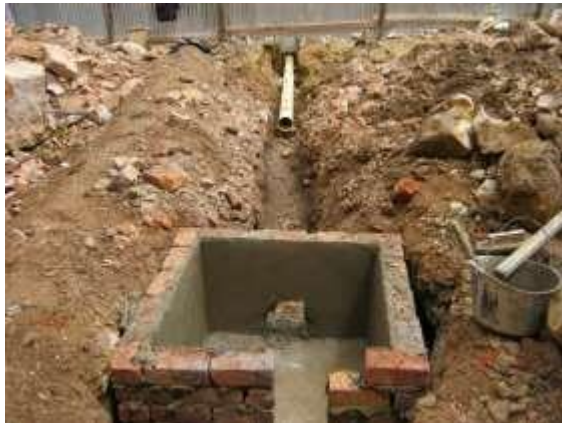
Excavación para acometidas sanitarias.
