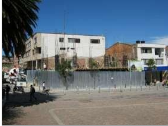
Fundición columnas nivel +2.94M.
