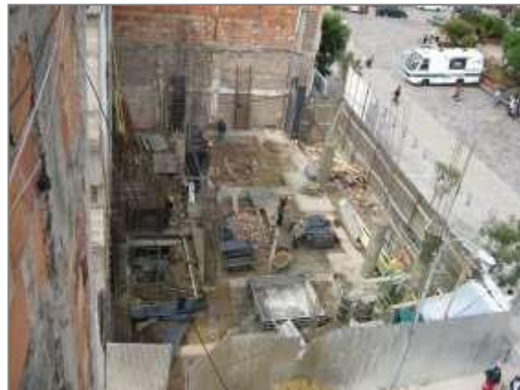
Fundición columnas nivel +0.00M.
