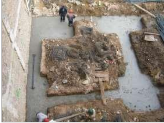
Concreto de limpieza.
