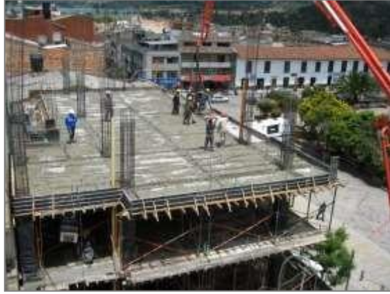
Fundición placa nivel +8.81M.
