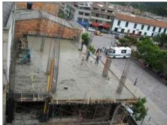
Fundición placa nivel +5.88M.
