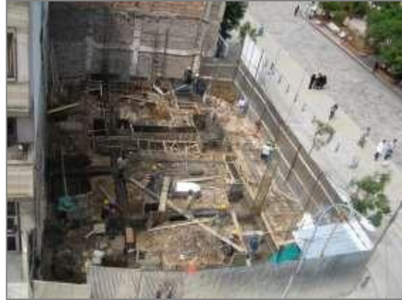
Amarre acero de refuerzo cimentación.
