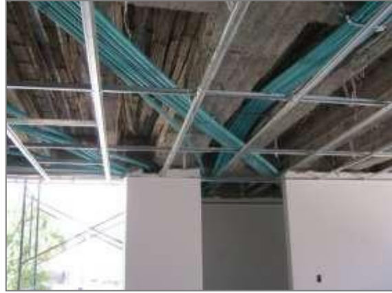
Extendidas tuberías (eléctricas, voz y datos) bajo placa nivel +8.81M.
