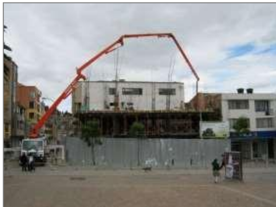
Fundición placa nivel +5.88M.
