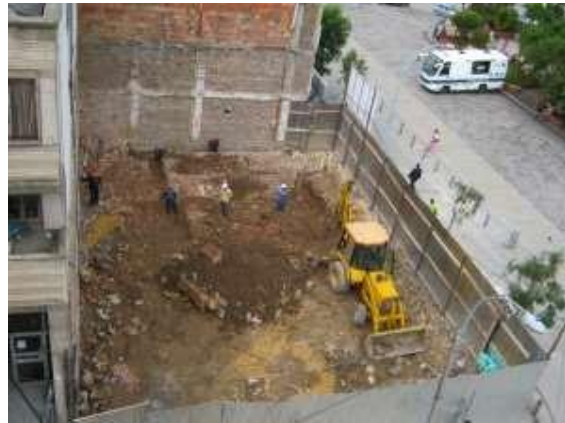
Excavaciones para cimentación.
