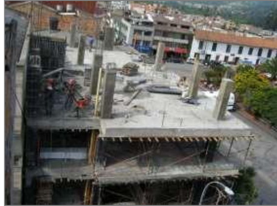
Fundición columnas +5.88M.
