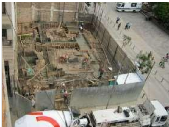
Fundición cimentación.
