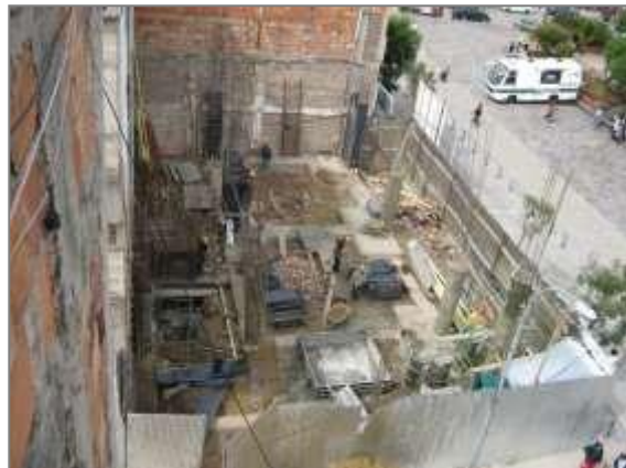
Fundición columnas nivel +0.00M.
