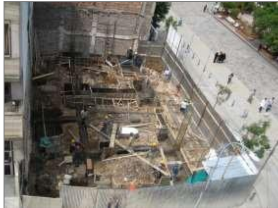
Amarre acero de refuerzo cimentación.
