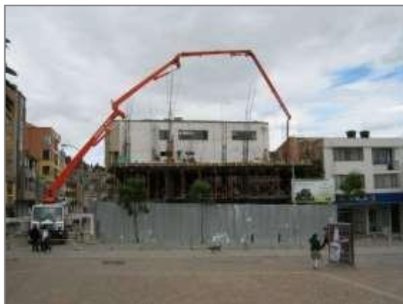
Fundición placa nivel +5.88M.
