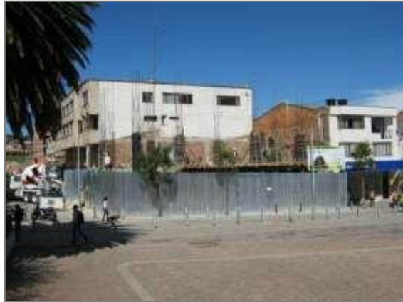
Fundición columnas nivel +2.94M.
