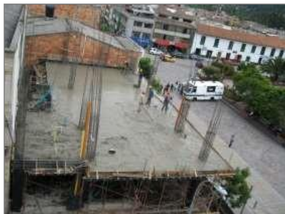
Fundición placa nivel +5.88M.
