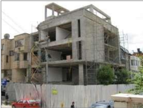
Estuco y pintura muros interiores.
