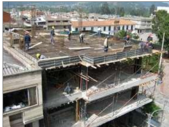
Amarre acero de refuerzo placa nivel +11.74M.
