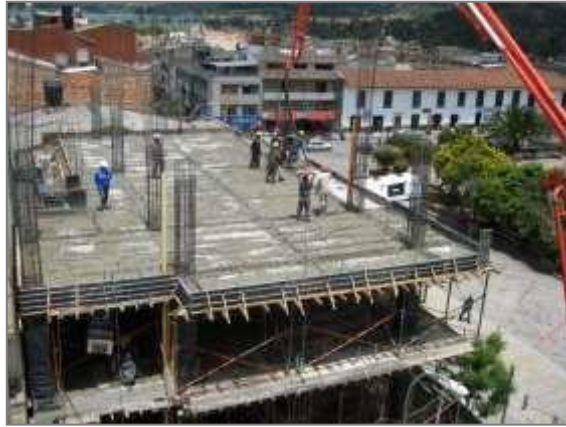
Fundición placa nivel +8.81M.
