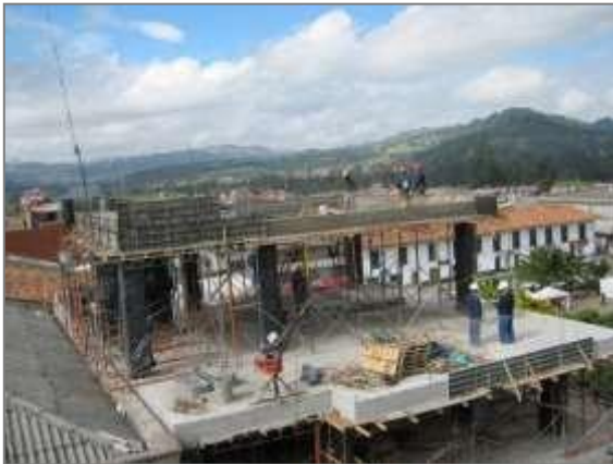
Desencofre vigas aéreas nivel 15.34M.
