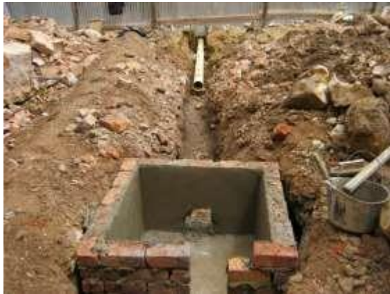
Excavación para acometidas sanitarias.
