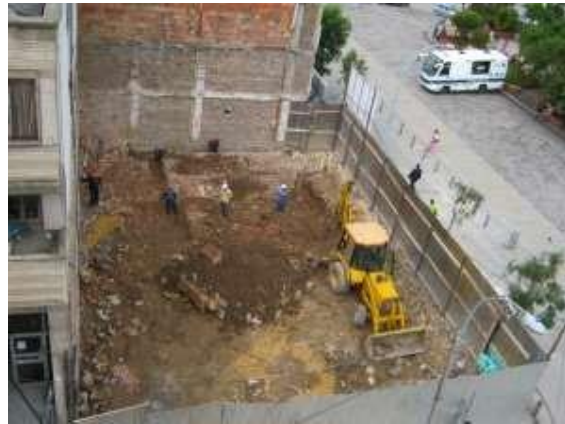
Excavaciones para cimentación.
