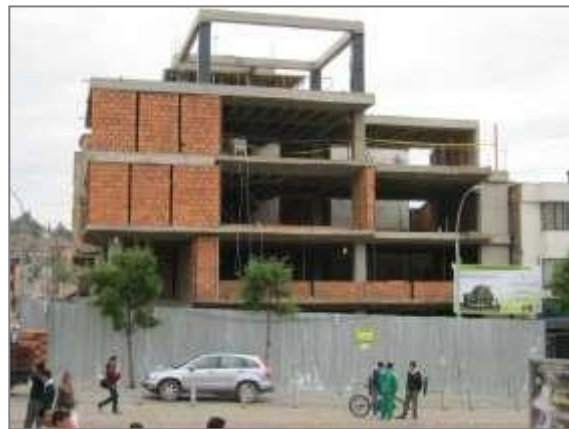
Mampostería (anclajes, grafiles, amarre acero de refuerzo columnetas y viguetas).
