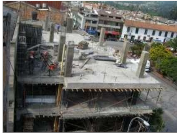
Fundición columnas +5.88M.
