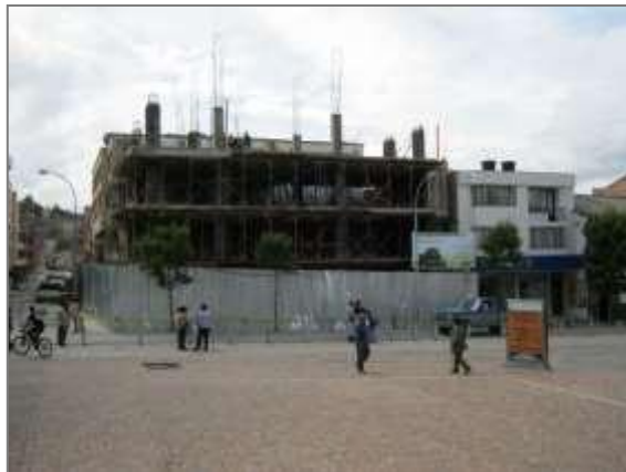
Fundición nivel +5.88M.
