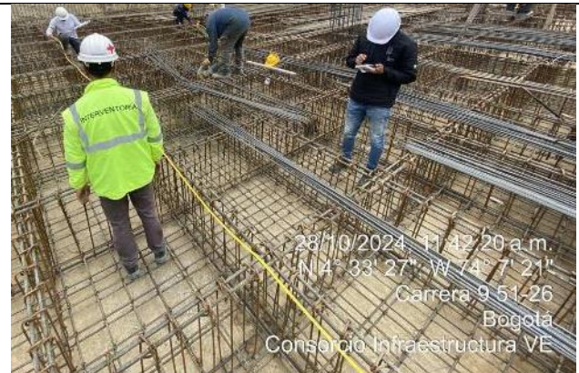
Armado de acero para placa de cimentación 28/10/2024
