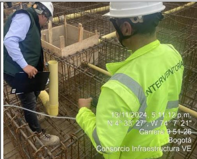
Armado de acero para cimentación 25/10/2024
