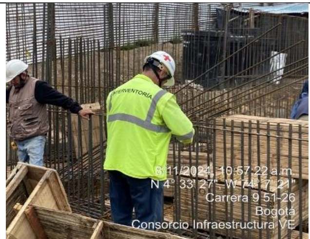
Armado de acero para pantallas 08/11/2024
