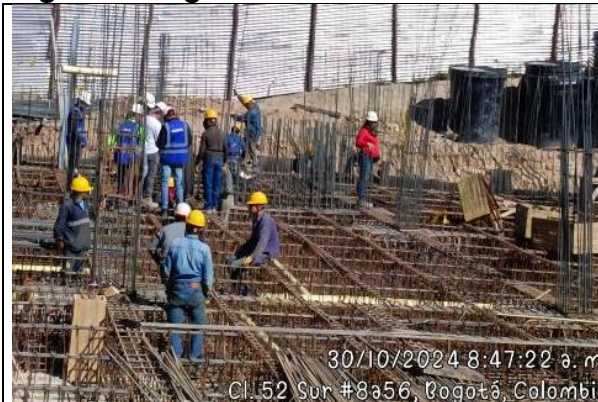
Armado de acero para placa de cimentación 30/10/2024
