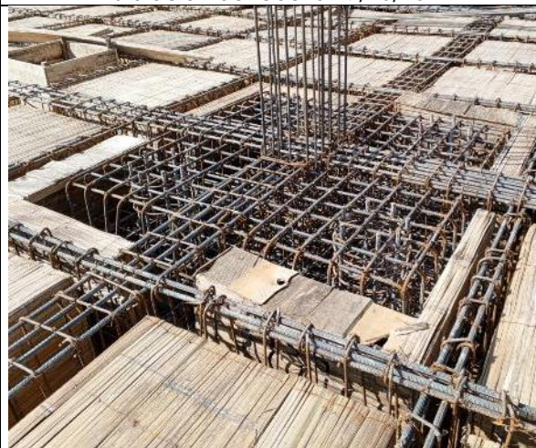
Armado de acero para dados 8/11/2024
