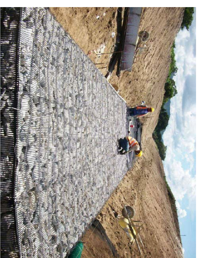
RECUBRIR CANAL EXISTENTE CON COLCHOGAVION
