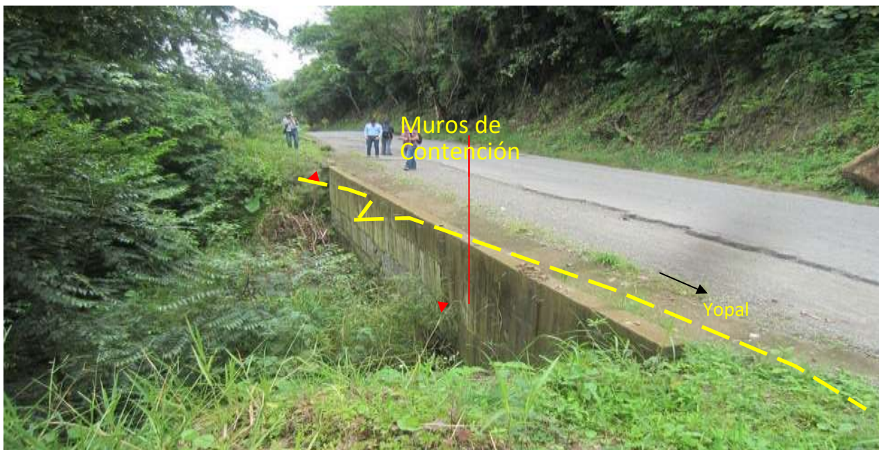
Fotografía 2. Muros de contención existente construido recientemente por EQUION
