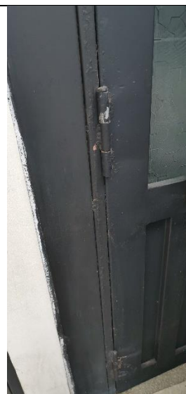
Mal estado en bisagras de la puerta del garage
