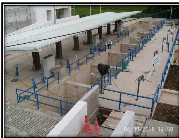
Fotografía No. 5 Avance de ejecución Filtros (Panorámica actual de avance).
