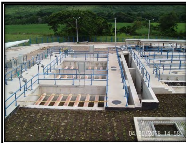
Fotografía No. 4 Avance de ejecución Sedimentadores (Panorámica estado actual de avance).
