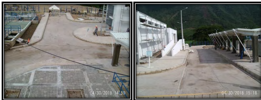
Fotografía No. 15 Avance de ejecución vías (Panorámicas de avance de vaciado de losas de pavimento vía 1 y vía 2)
