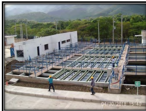
Fotografía No. 11 Avance de ejecución Optimización PTAP Existente (Panorámica estado actual).
