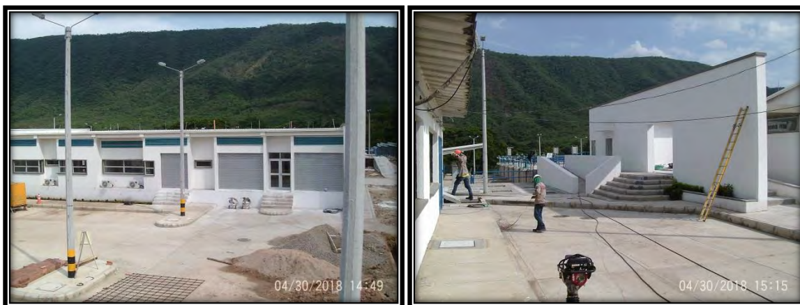
Fotografía No. 6 Avance Edificio Administrativo (Panorámica fachadas norte y sur).
