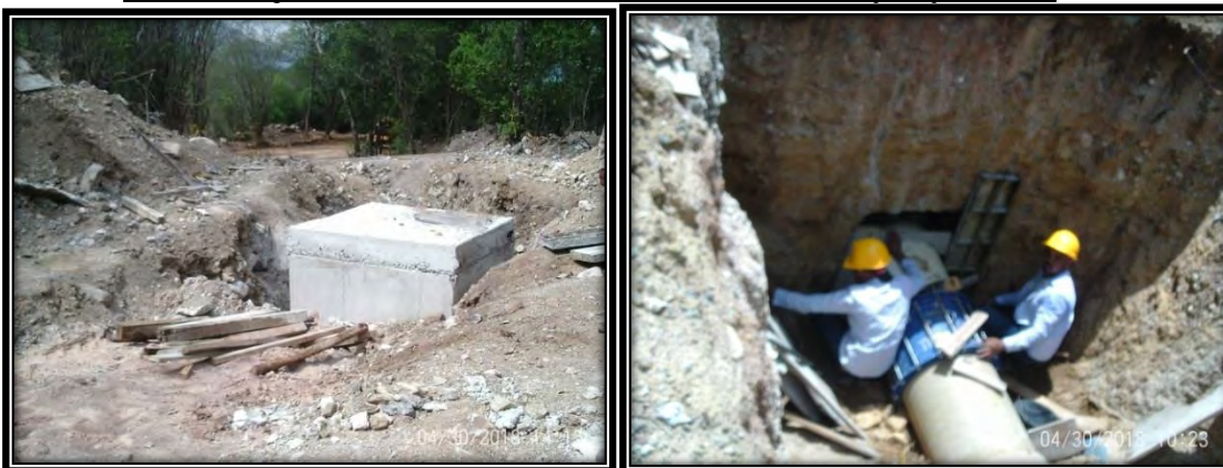
Fotografía No. 10 Avance de ejecución línea de aducción y by pass (Excavación e instalación de tubería en la línea de aducción, encofrado y vaciado de bloques de anclaje).
