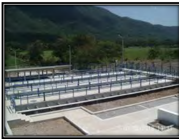
Fotografía No. 3 Avance de ejecución Floculadores (Panorámica actual de avance).
