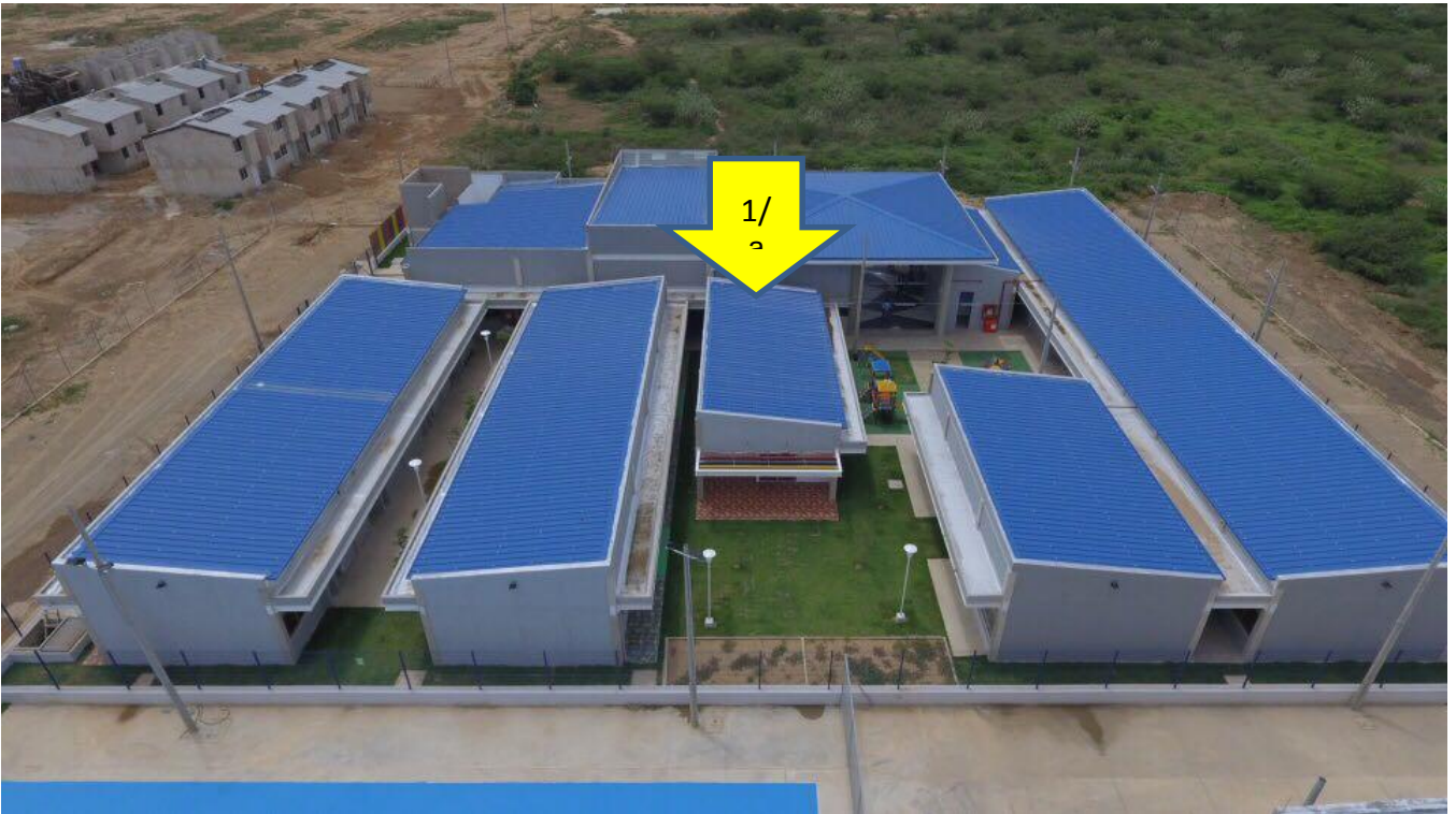
Ilustración 3 Cubiertas del CDI vistas desde el colegio
