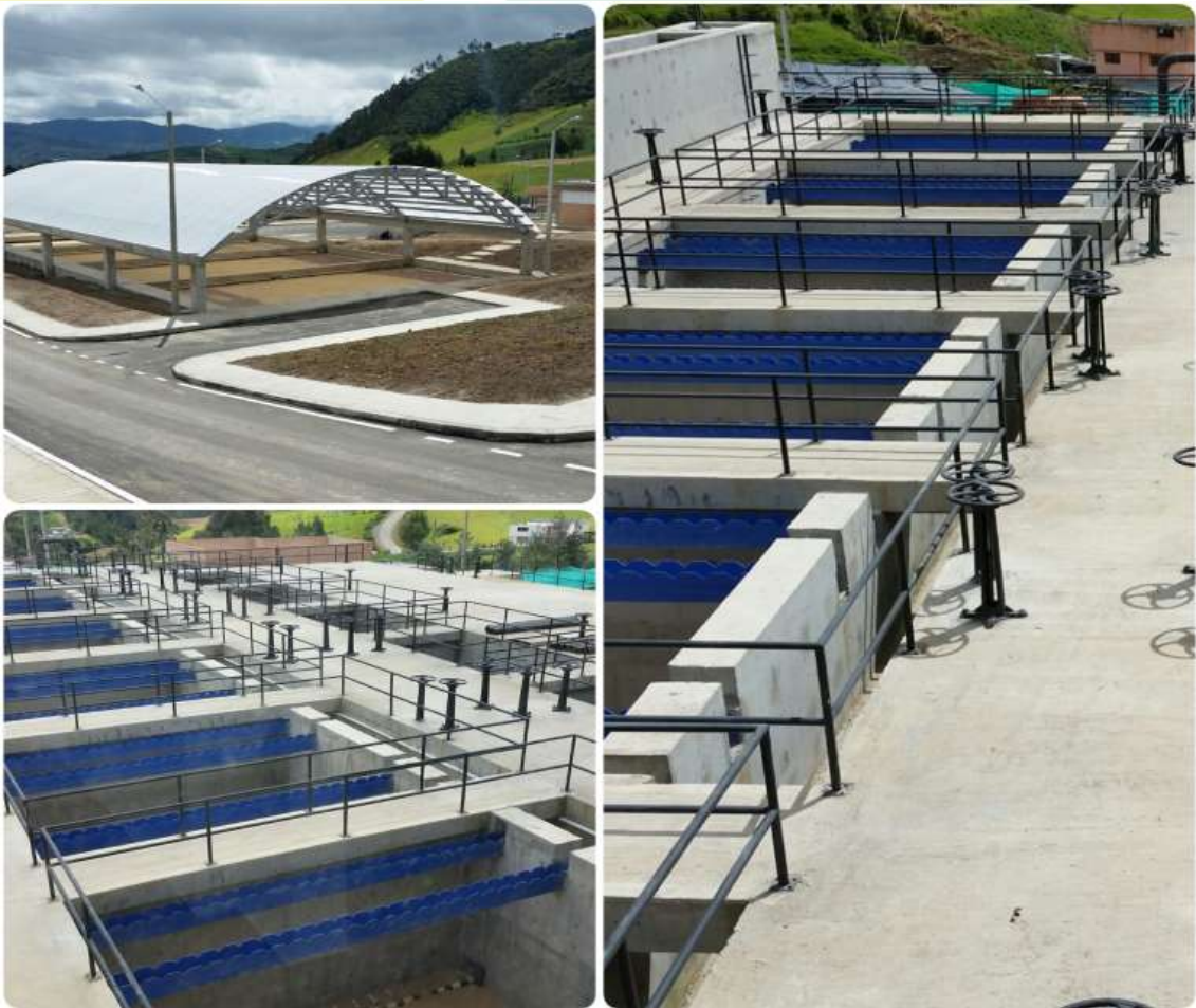
Pasto, Nariño Construcción Ptar Quebrada Piedras Fase2 Valor: $30.424 millones Población Beneficiada: 23.139 Habitantes
