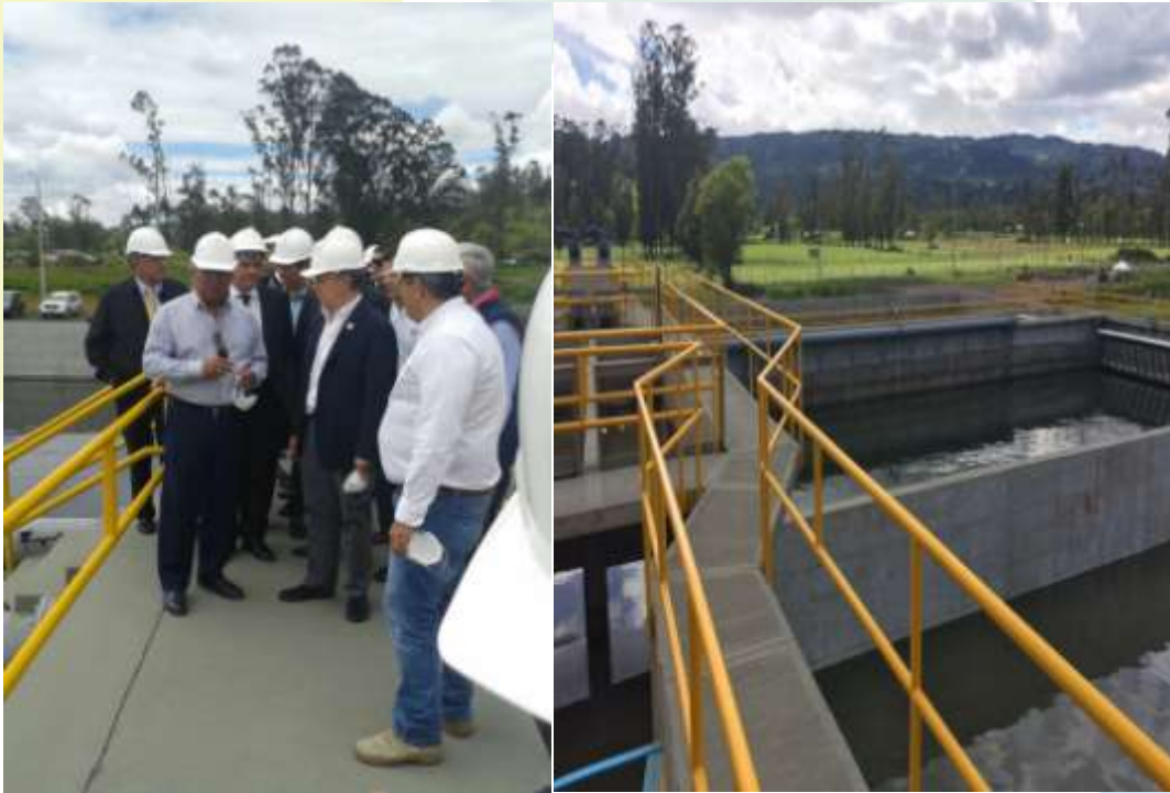
Chiquinquirá, Boyacá Construcción Planta de Tratamiento de Aguas Residuales Domésticas (Ptr) Valor: $21.142 millones Población beneficiada: 69.583 habitantes
