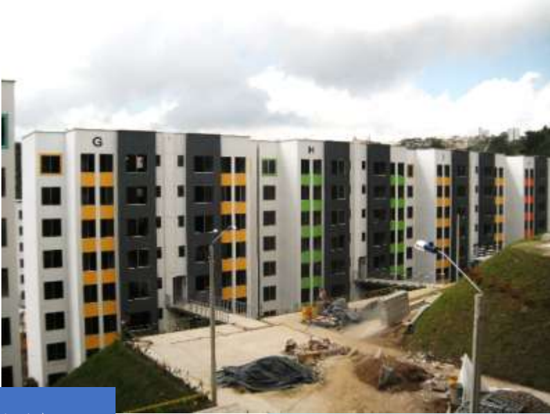
PARQUE DE LAS GARZAS Popayán, Cauca (800 viviendas)
